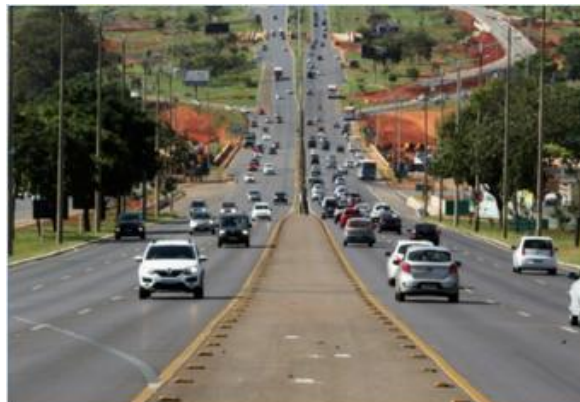
Figura 06 - Rodovia federal com superfície física multifaixas.
