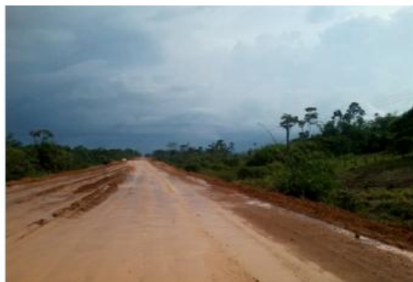
Figura 03 - Rodovia federal com superfície física implantada.
