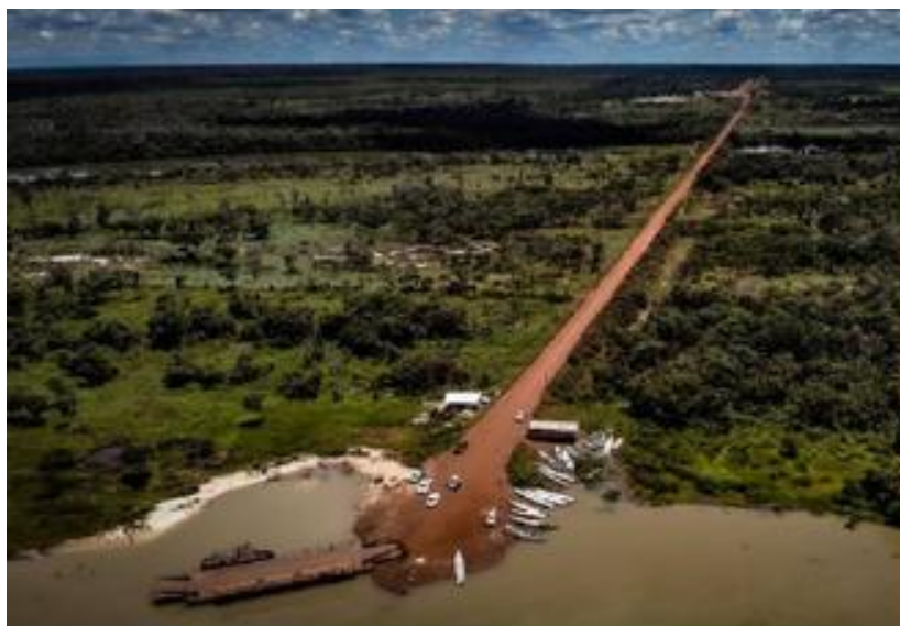
Figura 08 - Rodovia federal com superfície física travessia.
