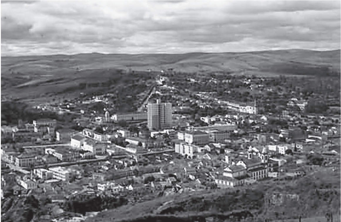
Figura 5 – Edifício São João del Rei (1955), São João del Rei.
